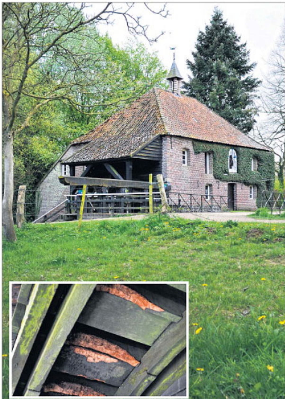
De bevers hebben geknaagd aan de schoepen van het waterrad van de molen in Leudal.
